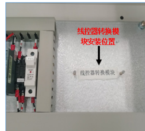
图 4 线控器转换模块安装位置图
