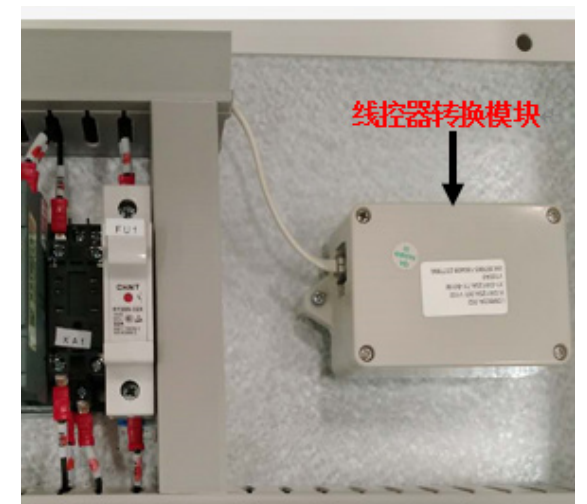
图 5 线控器转换模块安装后实物图
