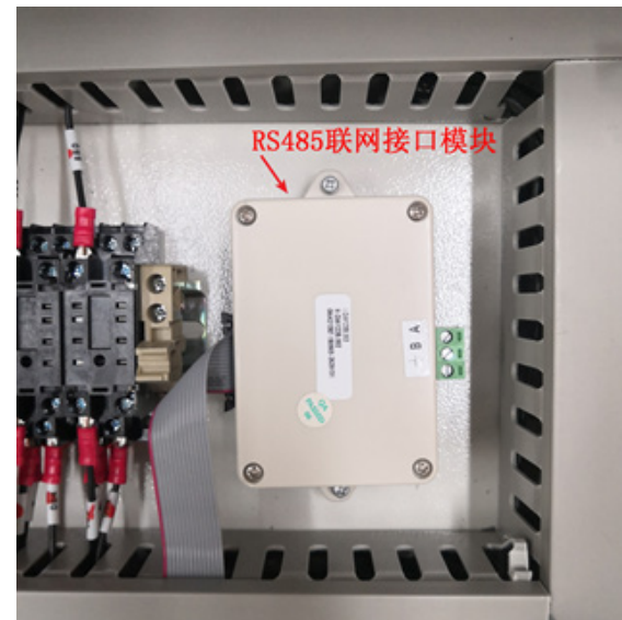
图 7 RS485 联网接口模块安装后实物图
